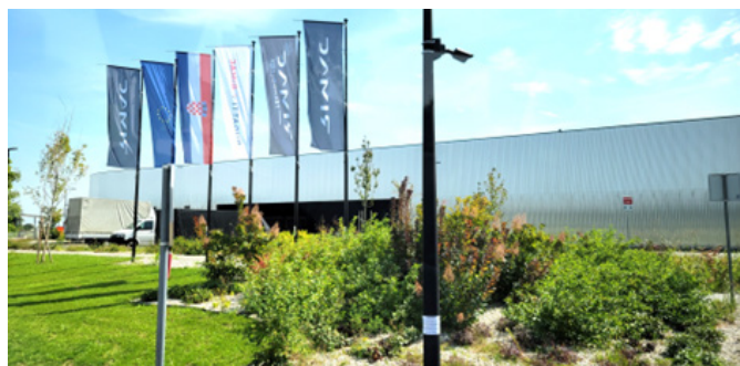
RIMAC工場外観（9/9）
